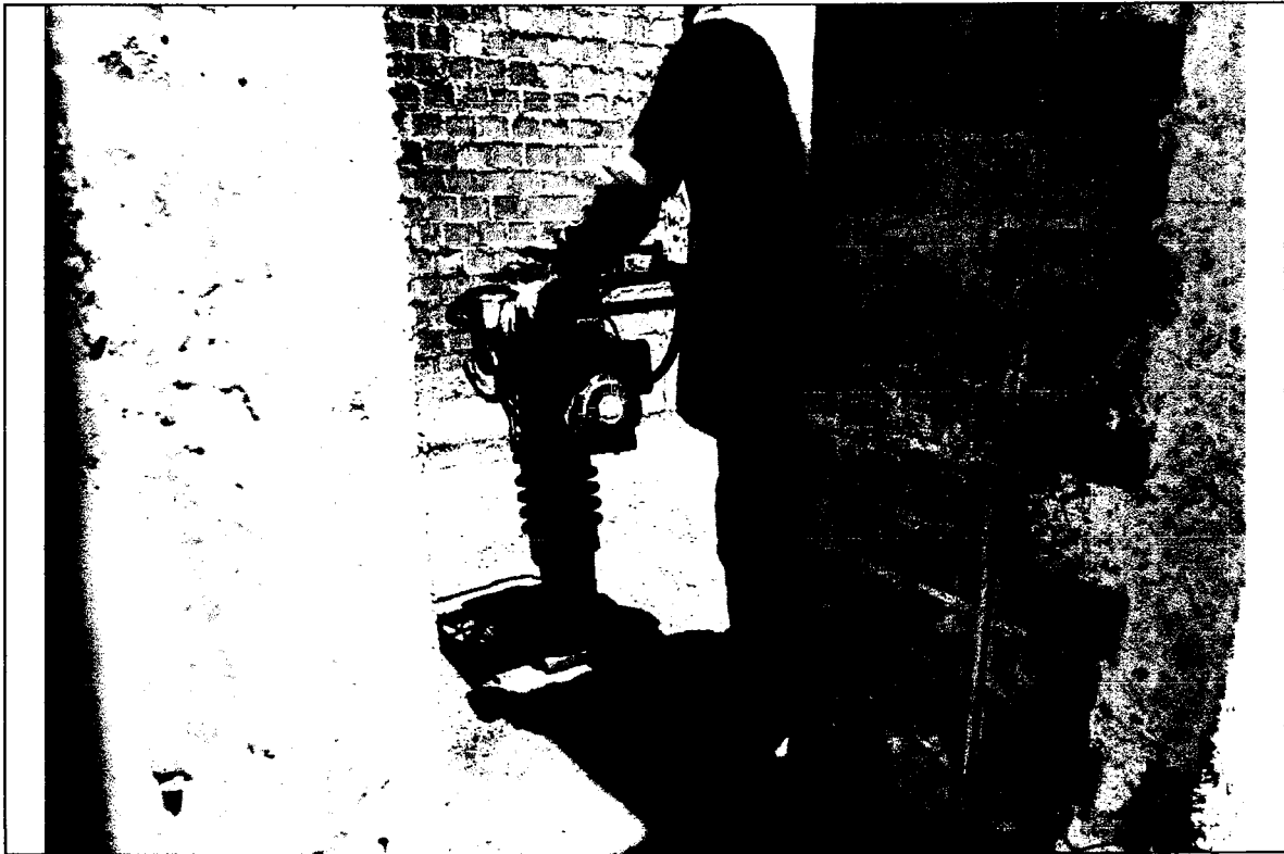
Foto N° 05: MEJORAMIENTO DE TERRENO CON PIEDRA GRANDE, PROCESO DE COMPACTACION DEL MATERIAL DE PRESTAMO EN EL MODULO II.
