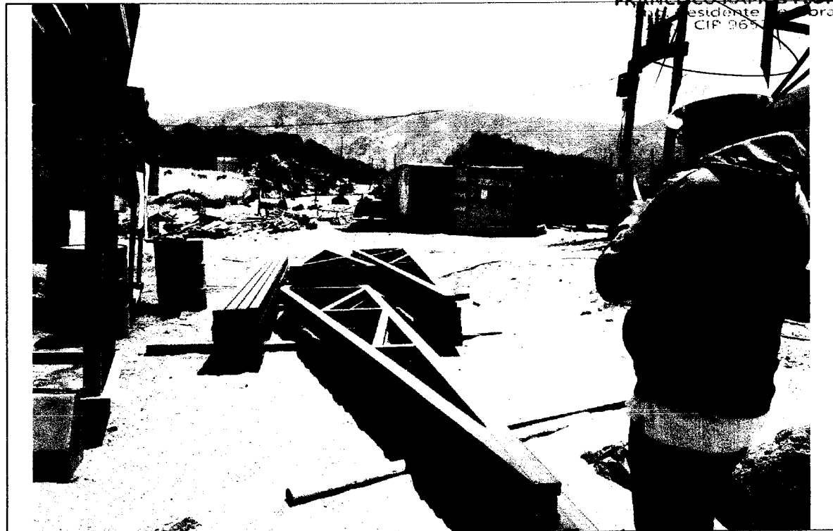
Foto N° 26: VERIFICACION DE LOS TIJERALES Y CORREAS POR PARTE DEL SUPERVISOR ANTES DE SU INSTALACION A LOS MODULOS.
