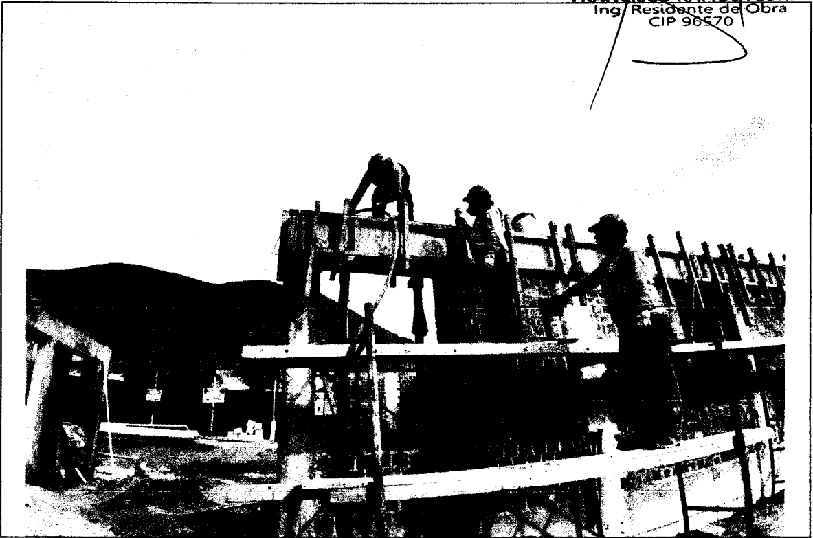
Foto N° 16: VACIADO Y VIBRADO DE CONCRETO F'C=210 kg/cm2 EN VIGAS DEL MODULO II.
