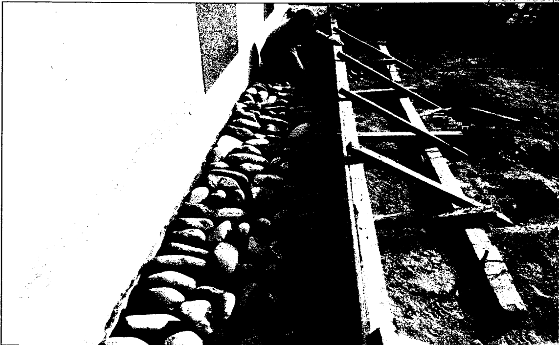
Foto N° 08: MEJORAMIENTO DE TERRENO CON PIEDRA GRANDE, PROCESO DE EMPEDRADO EN VEREDAS.
