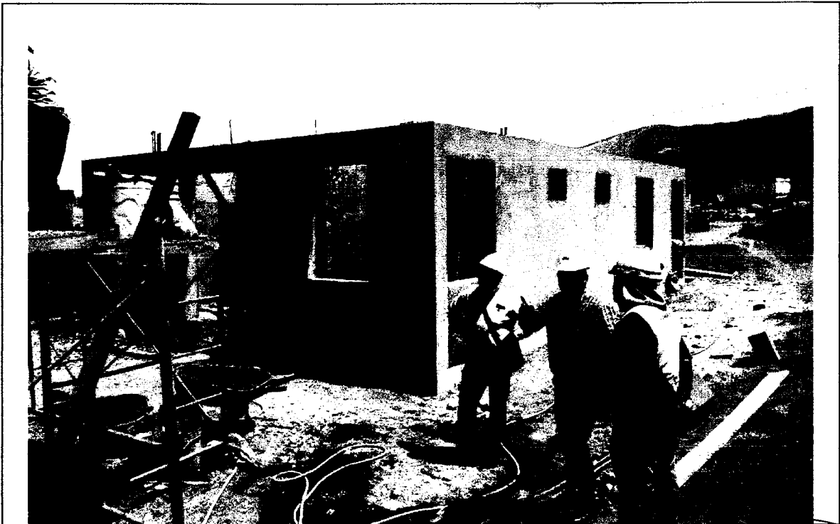
Foto N° 21: VERIFICACION Y COORDINACION ENTRE EL SUPERVISOR, RESIDENTE Y MAESTRO DE OBRA CON RESPECTO AL TARRAJEO DE LOS MODULOS.
