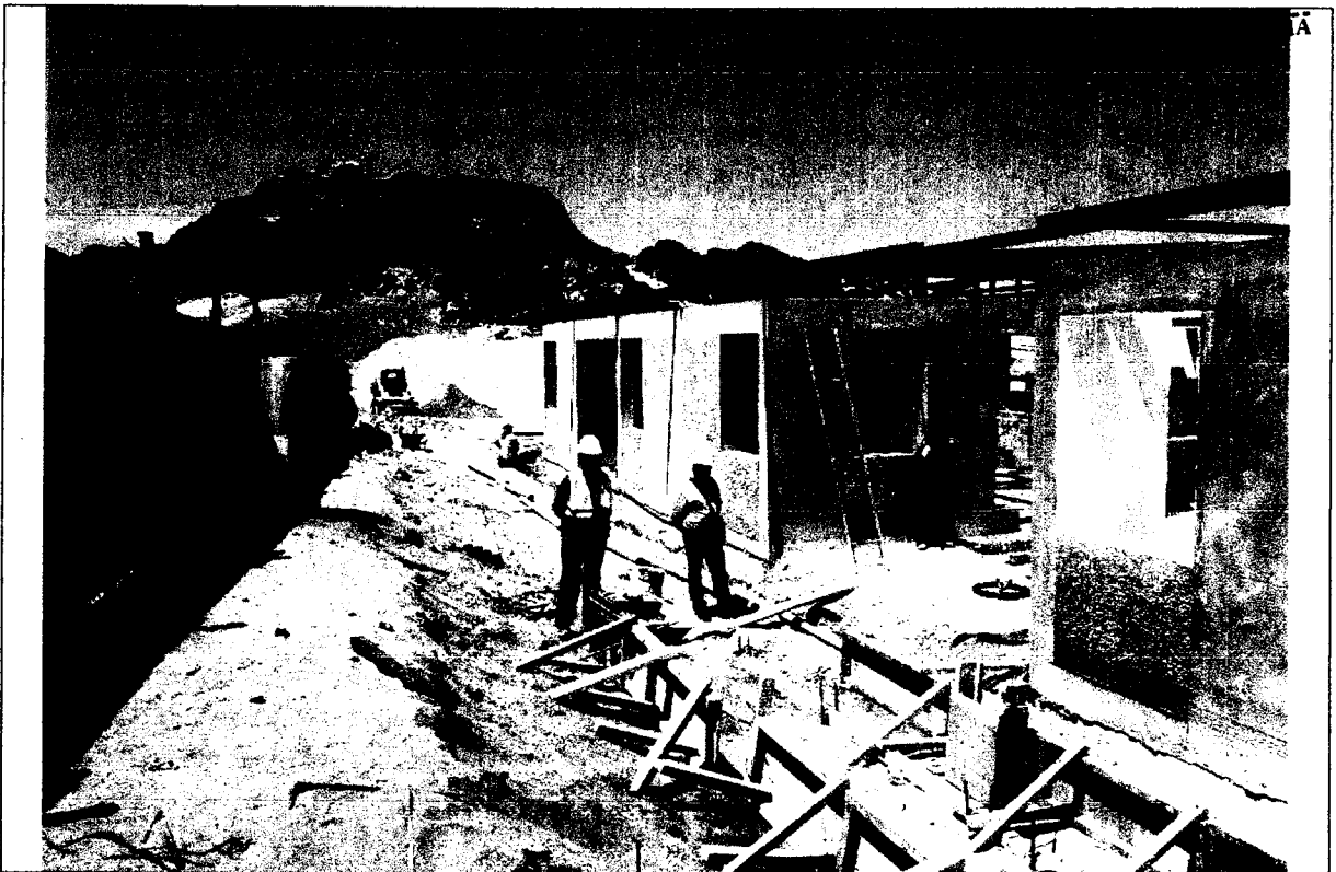
Foto N° 28: VISTA DE LA INSTALACION DE TIJERALES METALICOS EN EL MODULO II EN PRESENCIA DEL SUPERVISOR DE OBRA.
