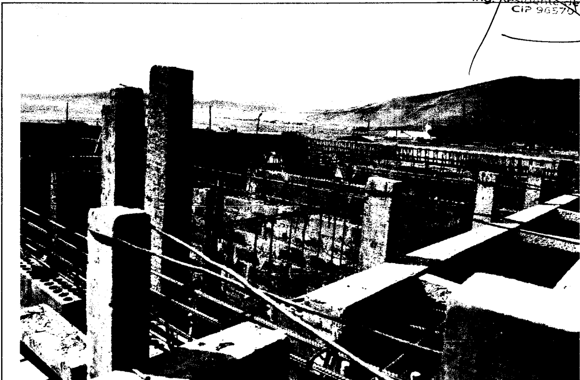
Foto N° 14: VISTA DEL ACERO DE REFUERZO EN VIGAS Y VIGUETAS DEL MODULO II.
