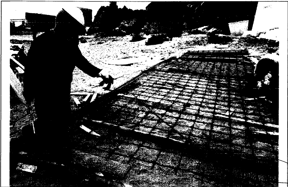
Foto N° 07: ARMADO DE LA MALLA DE ACERO DE REFUERZO PARA PATIO CENTRAL.
