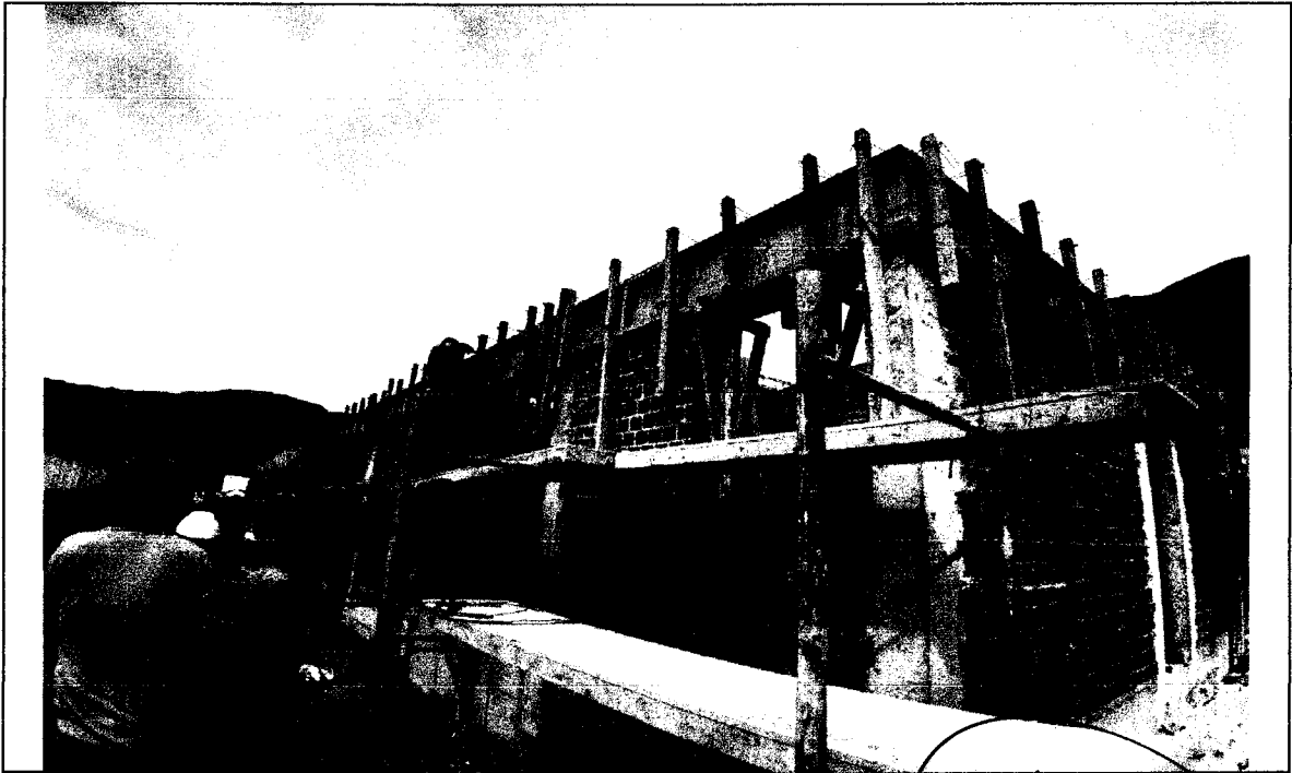
Foto N° 15: ENCOFRADO DE VIGAS DEL MODULO II.
