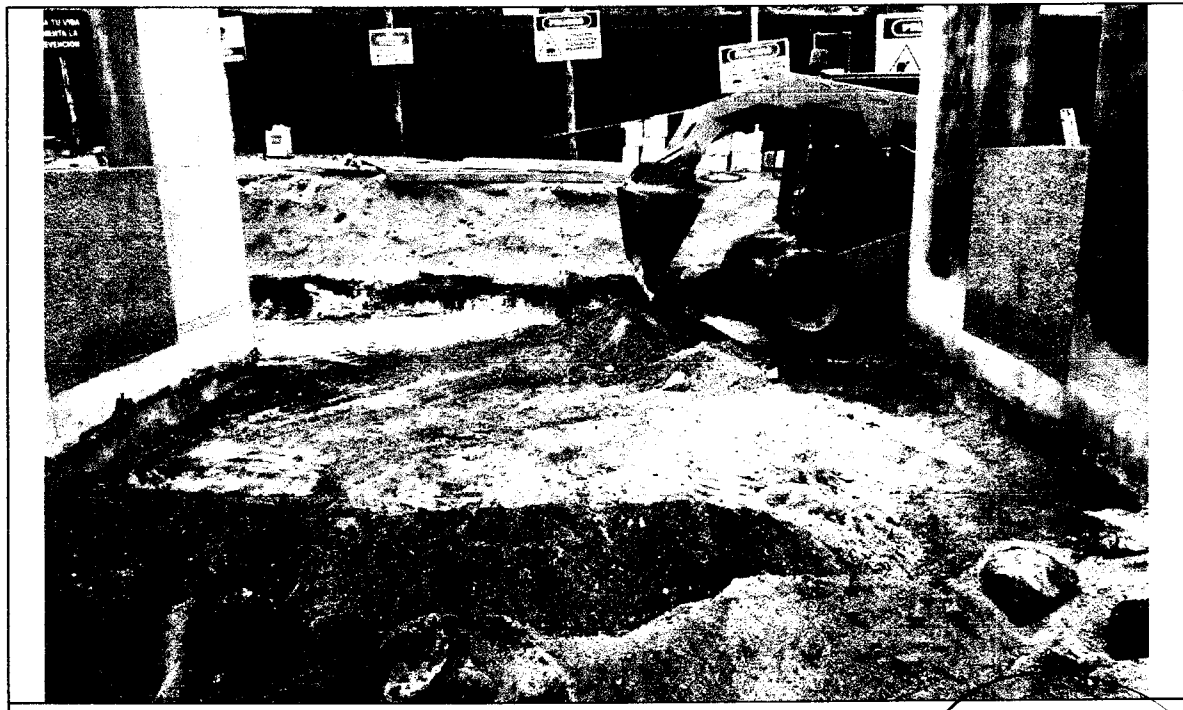
Foto N° 25: CONFORMACION DE TERRENO NATURAL EN PATIO CENTRAL Y VEREDAS CON MINICARGADOR. IMELEC S.R.L.
