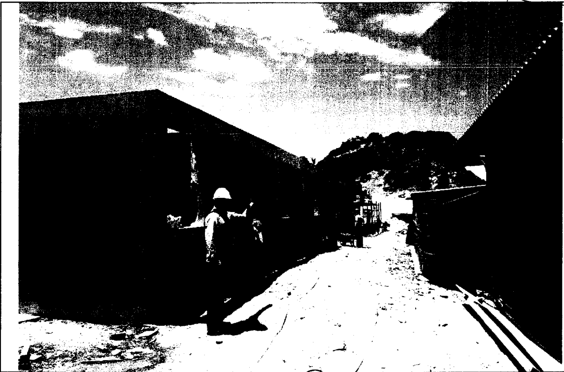
Foto N° 24: VERIFICACION DEL SUPERVISOR DE OBRA DE LOS TRABAJOS QUE SE VIENEN EJECUTANDO.
